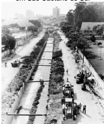
Imagem 1: Canalização do córrego do Moinho em São Caetano do Sul
